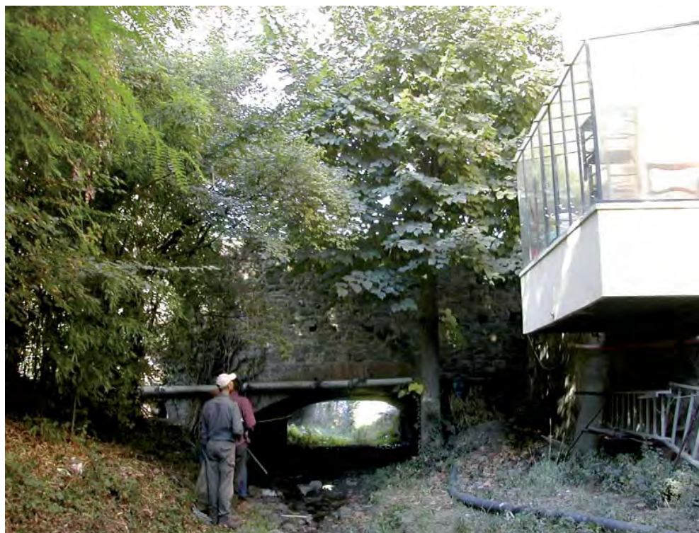
Figura 7 - Torrente Ema, località Bottai (FI): attraversamento stradale con rilevante restringimento della sezione di deflusso. (foto di G. Calamini).
